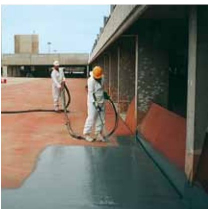
Aufbringung der Dichtungsschicht (hwO) mit der Maschine.
