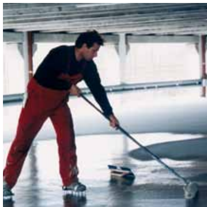
Aufbringen der Grundierung und des Abstreusandes
