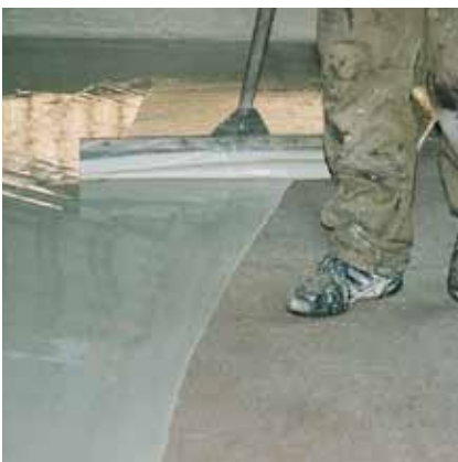
Aufbringung der Dichtungsschicht (hauptsächlich wirksame Oberflächenschutzschicht) von Hand.
