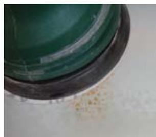
Schadhafte Stellen anschleifen mit Schleifgitter oder abrasiven Pad. Ggfls. Reinigen mit alkoholischen Reinigern und Abtrocknen lassen. Bei partiellen Sanierungen Schadstelle durch Abkleben begrenzen
