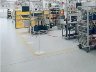
Leitsets bestehen aus Dübeln, die fest mit dem Untergrund verbunden werden. Über einen Kabelschuh kann auf sehr einfache Weise die Verbindung zur Erdung hergestellt werden. Der schwarze Leitlack, der über die Bänder aufgerollt wird, besitzt in horizontaler Richtung eine viel höhere Leitfähigkeit als der Beschichtungsstoff.
