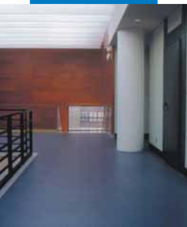
Linoleumverlegung auf Ultraplan. Monzon - Konservatorium - Spanien
