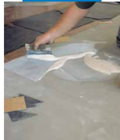
Beispiel einer PVC-Intarsienverlegung auf Ultraplan. CD2 - Mailand - Italien
