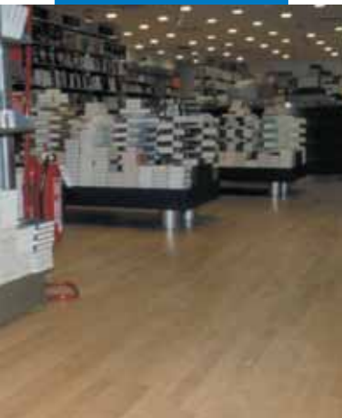
Fertigparkettverlegung (schwimmend) auf Ultraplan. Messagerie Musicali - Rom (Italien)
