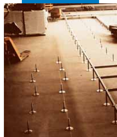
Ausgleich von Unebenheiten einer Betondecke vor der Herstellung eines Doppelbodensystems
