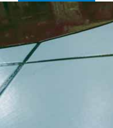
Detail zur Verarbeitung von Ultraplan auf mit Mapeprim SP grundierter vorhandener Keramik
